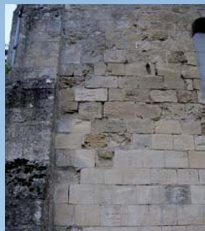
*Pierres posées lors de la restauration de 1940 : déjointement et altération généralisé.*
