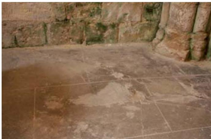
*Fissuration et soulèvement du sol en ciment de la nef angle Nord-Ouest.*
