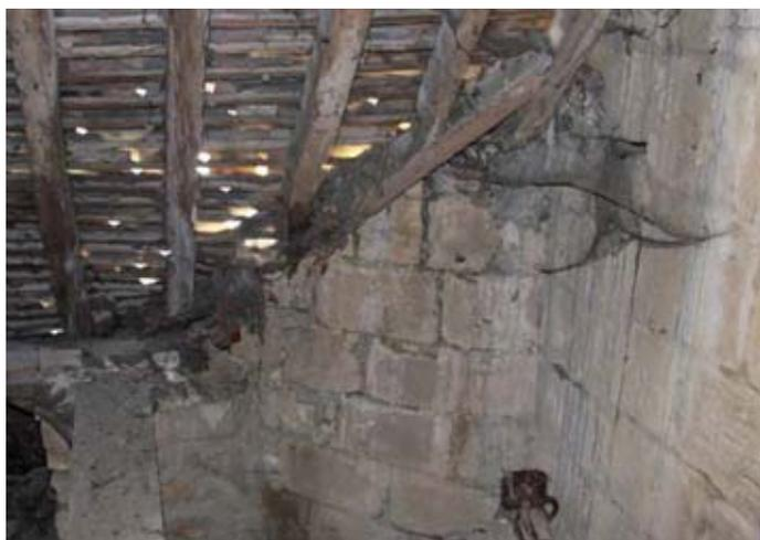
*Infiltration d'eau dans les maçonneries de la tourelle entraînant le déjoints et la présence d'humidité stagnante dans les reins de voûtes.*
